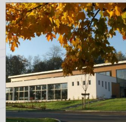
MÉDIATHÈQUE DE FRANCHEVILLE (69)
