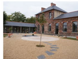
Médiathèque La Parchemine de Pleumeleuc
